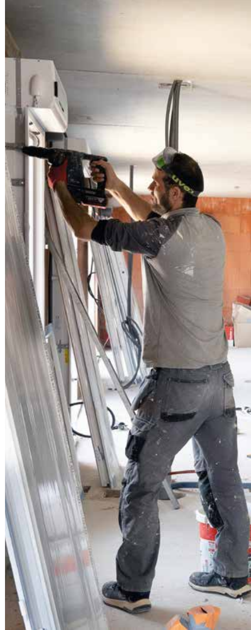
Chantier à Poitiers. Les entreprises ayant eu recours aux PGE sont surtout des TPE-PME des secteurs de la construction, du commerce et de l'hébergement-restauration.
